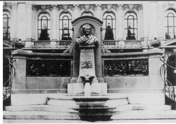
Abb. 22: Immermannbrunnen vor dem Stadttheater 1. Standort 1899 bis 1920/21
